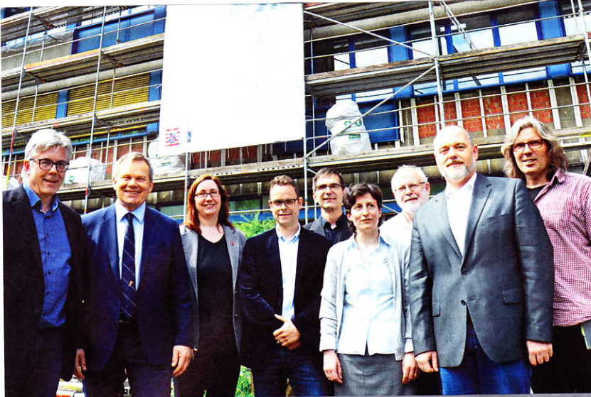
Kick-off für das städtische BildungsBauProgramm: An der Adolf-Reichwein-Schule hat die Fassadensanierung wie geplant begonnen - hier Oberbürgermeister Dr. Thomas Spies (2. v. l.) und Schuldezernentin Dr. Kerstin Weinbach (3. v. l.) mit Vertretern der Schulen sowie der Verwaltung beim Ortstermin.
